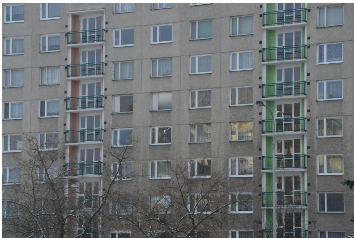
Snímek č. 2 – pohled na č.p. 1312 – 13
