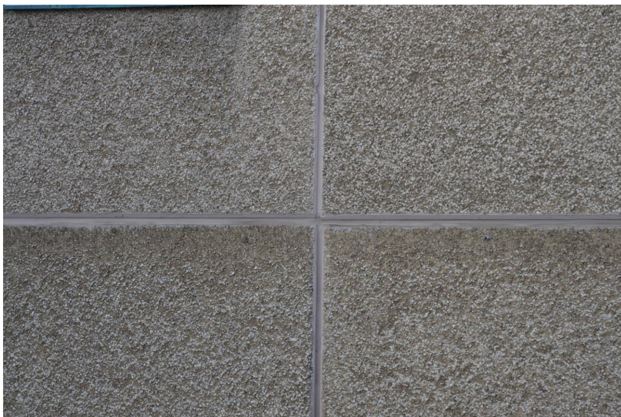
Snímek č. 5 – č.p. 1312 – rozmezí sklepy a bytové podlaží
