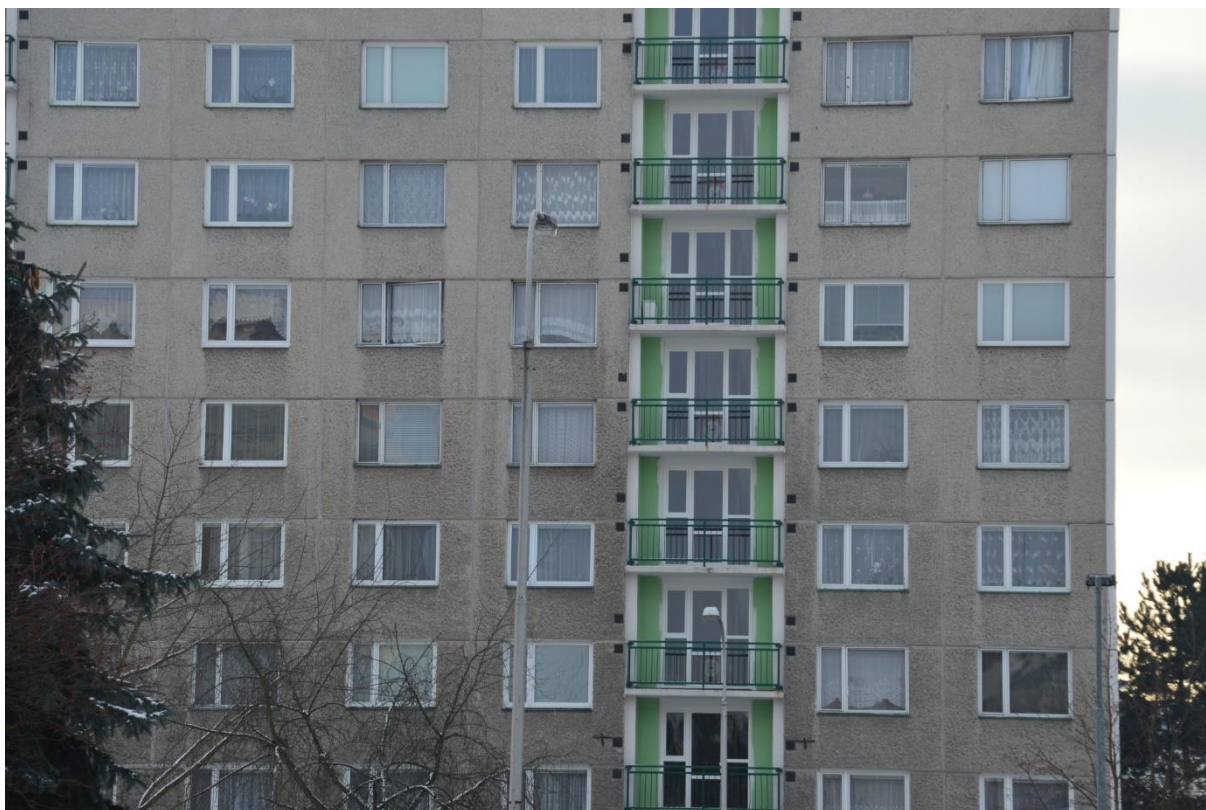
Snímek č. 1 – pohled na č.p. 1315
