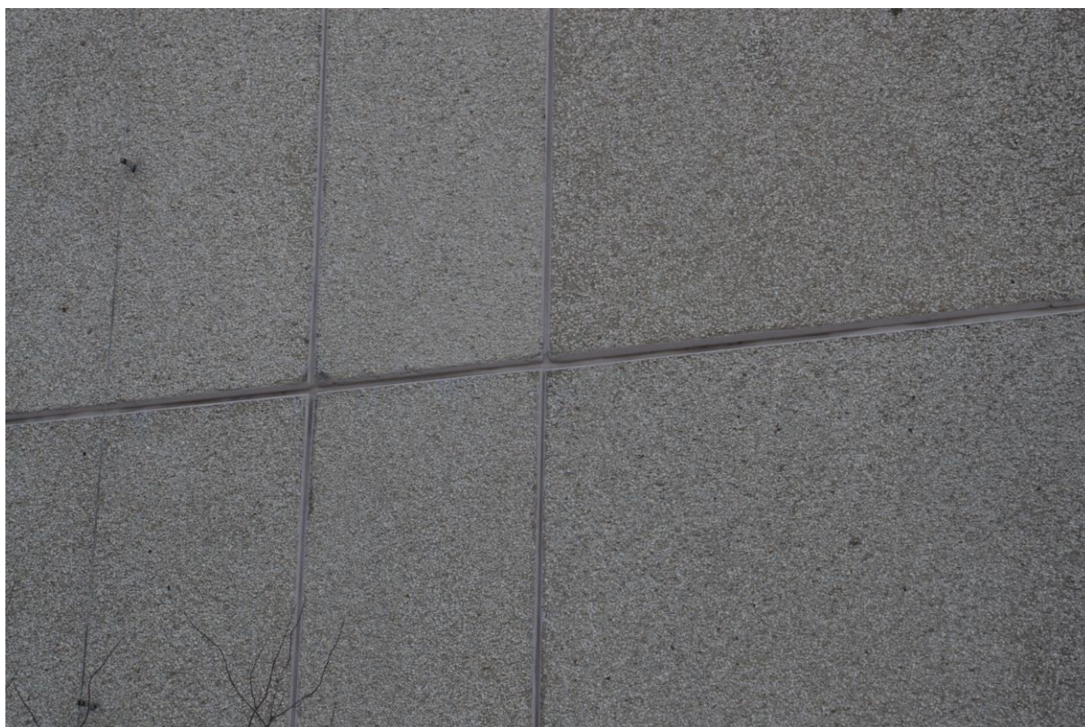
Snímek č. 11 – č.p. 1315 štítové stěna - 2. – 3. NP
